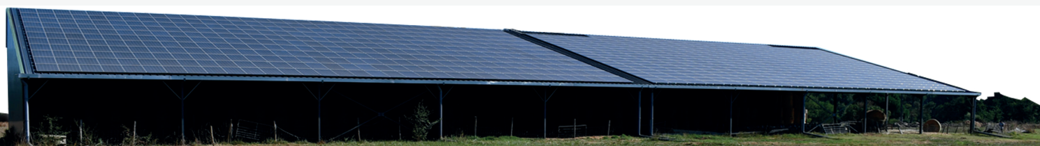
Hangar agricole photovoltaïque de Castelnau d'Auzan (32) - 200 kWc
