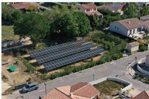
Arkolia a développé un schéma de modélisation des modes de consommation et des flux énergétiques dans un réseau intelligent à l'échelle d'un quartier. Sa première réalisation a été inaugurée en 2023 dans le Vaucluse une centrale photovoltaïque installée sur un bassin de rétention permet de couvrir 20% des besoins électriques de 90 maisons individuelles.
